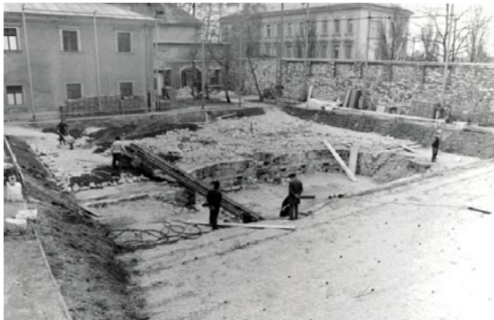
Gradbena dela ob razširitvi odra in orkestrskega prostora v Poletnem gledališču Križank / Construction works for the stage and orchestra space expansion in the Križanke Summer Theatre 1974
