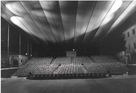
Poletno gledališče z Marinčkovo pomično streho Summer Theatre with Marinček's retractable roof
